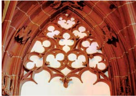
2 3 Die Rutenmaßwerke sowie die Maßwerkgewölbe in der Turmvorhalle des Frankfurter Doms führen bautechnische und -künstlerische Innovationen vor.
